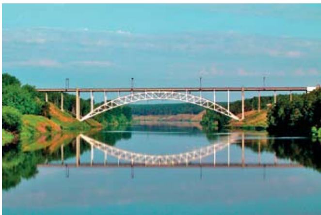
Рис. 6. Железнодорожный мост из трубобетонных арок через реку Исеть в Челябинской области, пролет моста 140 м, 1939 год
