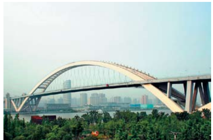
Рис. 7. Арочный мост ЛУПУ (Шанхай, КНР) из трубобетонных конструкций, пролет моста 550 м, 2009 год
