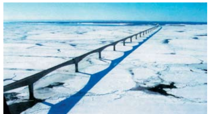
Рис. 8. Фото моста Конфедерации в Канаде, смонтированного из коробчатых большеразмерных железобетонных пустотелых коробчатых балок, стянутых в магистраль стальными канатами по технологии post-tension и опирающихся на колонны. Расстояние между осями опор 250 м. Высота магистрали над водной поверхностью около 50 м
