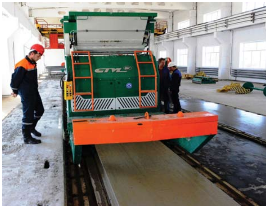
Рис. 2. Процесс виброформования железобетонной плиты перекрытия шириной 1,2 м «в один прием». Комбинат Индустриального Строительства, г. Семей, 20.09.13 г.
