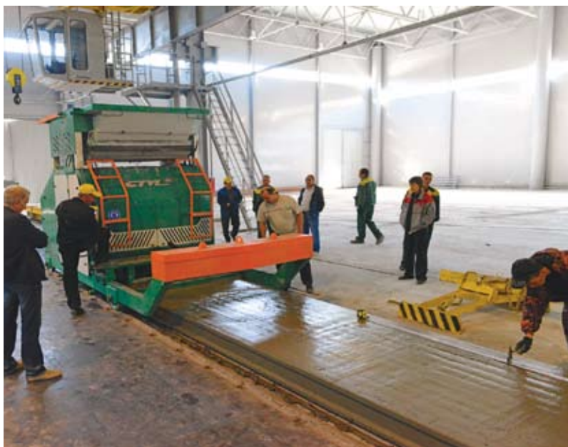
Рис. 1. Виброформование плиты перекрытия шириной 1,5 м в г. Березовский Свердловской обл., 14.08.13 г.
